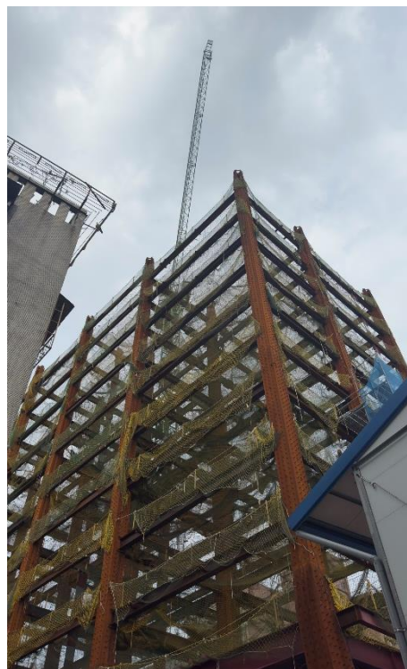
塔吊安裝完成
