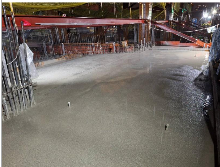
1 樓車道結構混凝土澆置
