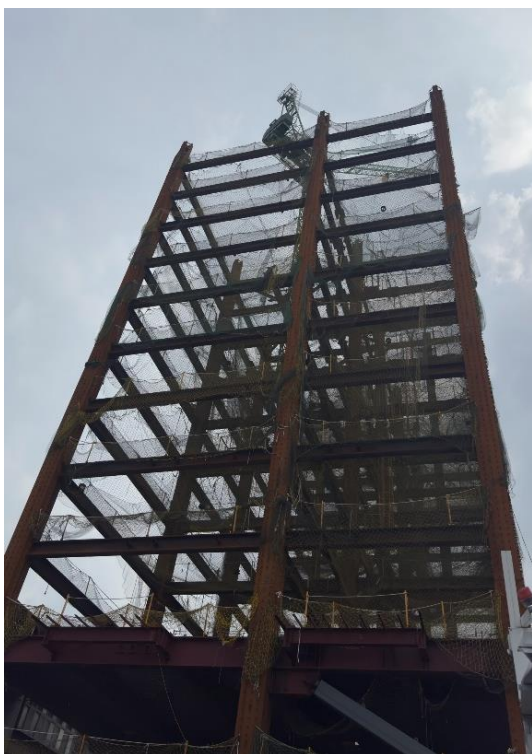
鋼構安裝完成
