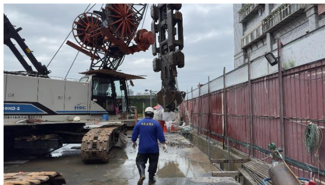
鋼筋籠製作吊放
